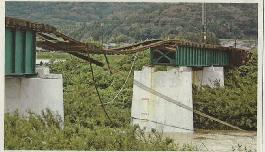
滋賀県甲賀市
