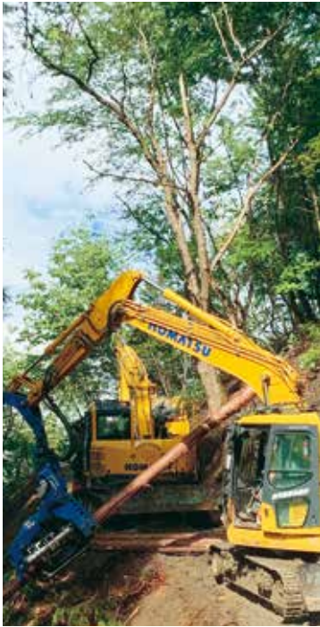
重機での作業
