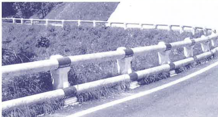
間伐材を加工し、防護柵や砂防などに利用されている
